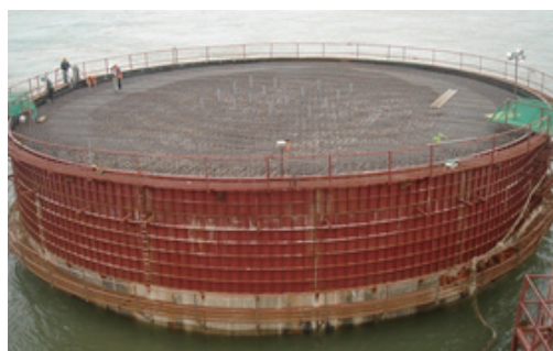
> Top Slab 철근 및 거푸집 조립
