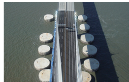
> 충돌방지공 설치 전경(W2-W4)
