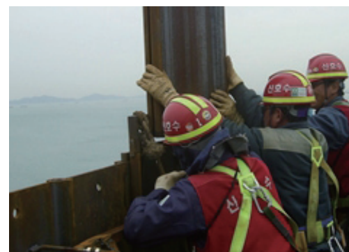
> Sheet Pile 조립
