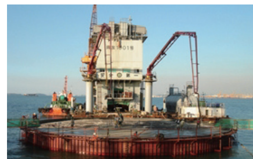
> Top Slab 콘크리트 타설
