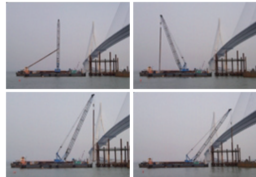
> Master Pile 설치 전경
