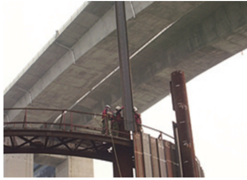
> Sheet Pile 조립 작업
