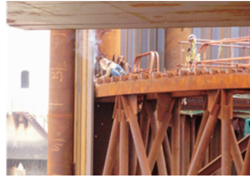
> Sheet Pile 조립 후 용접 고정
