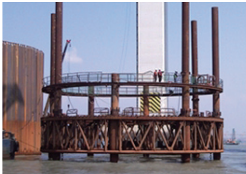
> Chaser Pile 용접 작업 전경
